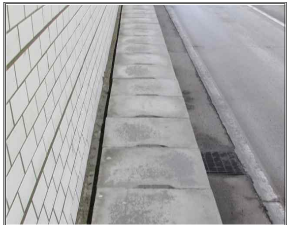
위 치 진부2터널(인천) 내 용 공동구 전경
