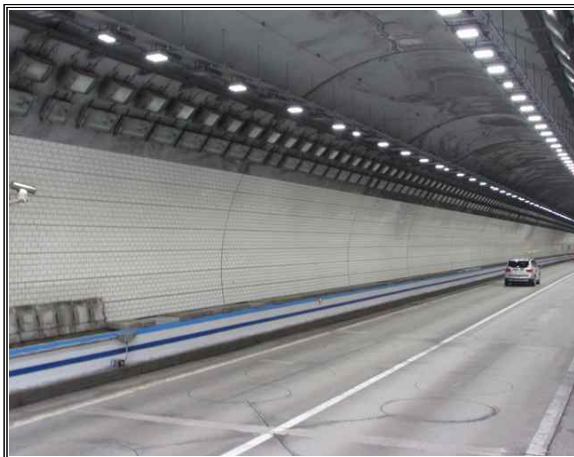
위 치 진부2터널(인천) 내 용 타일 전경
