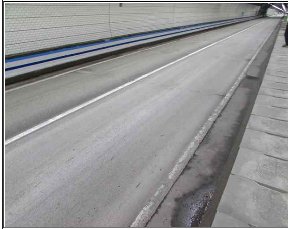
위 치 진부2터널(인천) 내 용 포장부 전경
