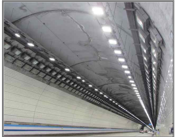
위 치 진부2터널(인천) 내 용 라이닝 전경
