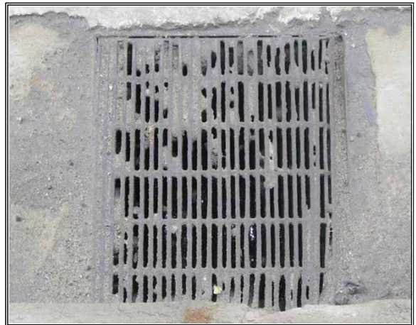
위 치 진부2터널(인천) 내 용 배수구 전경
