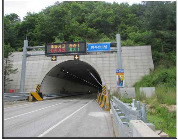
위 치 진부2터널(인천) 내 용 종점측 전경
