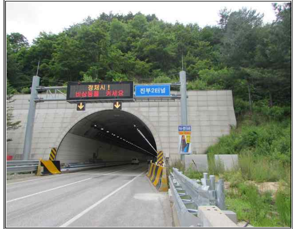
위 치 진부2터널(인천) 내 용 사면 전경
